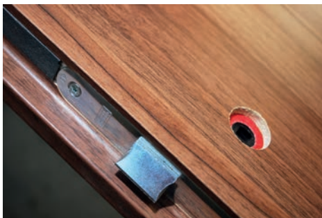
detail zámku protipožárních dveří
