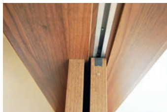
Detail posuvných dveří do zárubně
